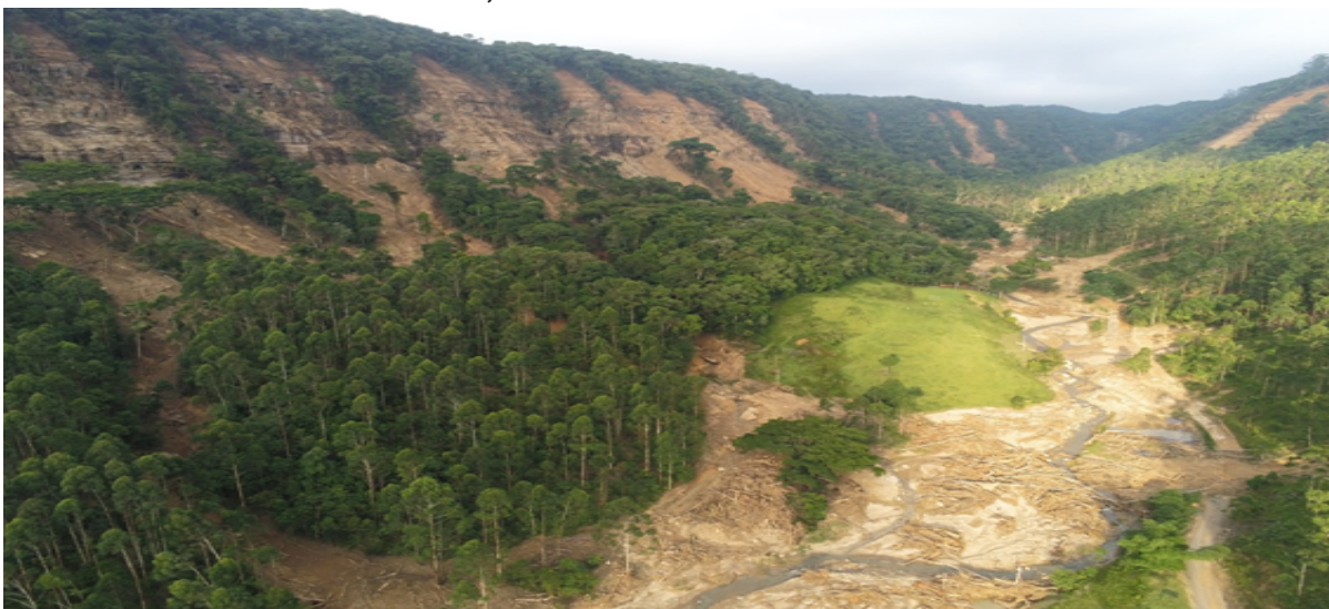
Figura 2 - Deslizamentos na Serra do Mirador - Divisa entre os Municípios de Rio do Sul, Presidente Getúlio e Ibirama
