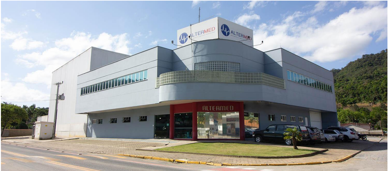
Figura 4 - Estrutura da Empresa
