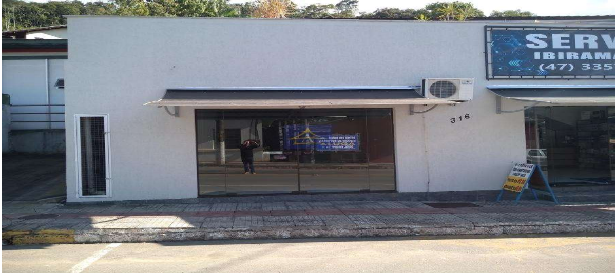
Imagem 1 – fachada do Imóvel
